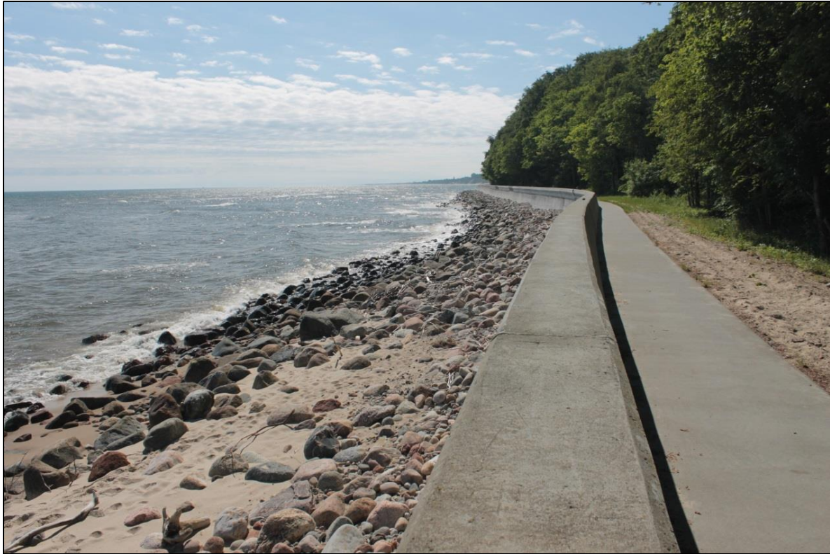
Fig. 3.11. Opaska betonowa zabezpieczająca klif rozewski (fot. R. Wróblewski)
