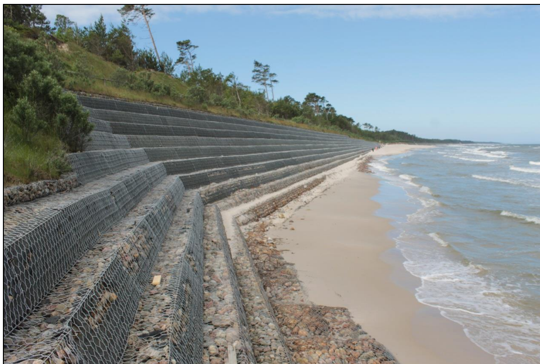
Fig. 3.13. Umocnienia brzegu wschodniego krańca Mierzei Karwieńskiej, rejon km 134,55 (stan 17.06.2019) (fot. R. Wróblewski)
