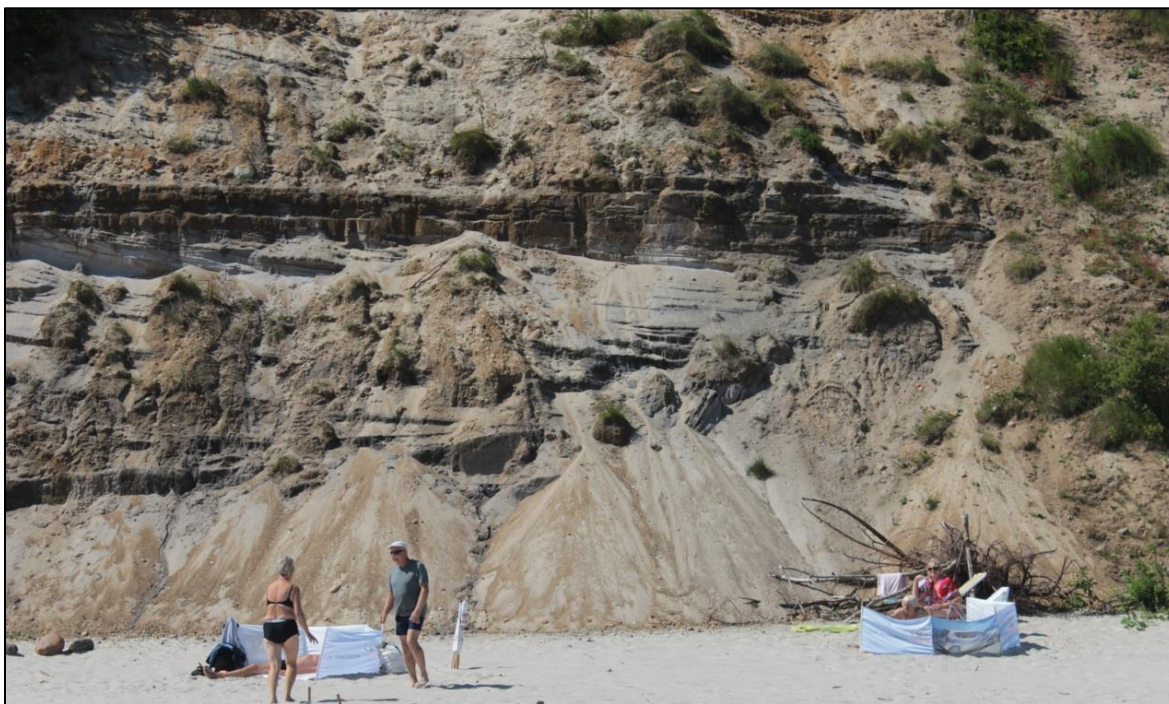
Fig. 3.10. Stożki osypiskowe u podstawy ściany klifu chłapowskiego, rejon km 127,4 (stan 17.06.2019) (fot. R. Wróblewski)
