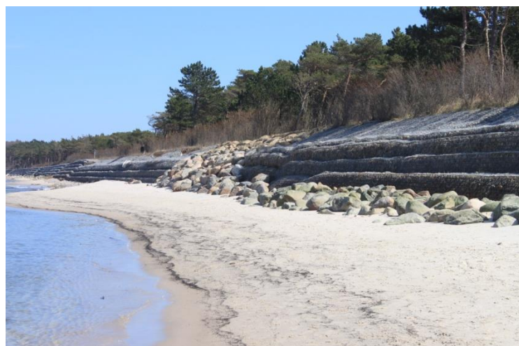
Fot. 130. Dewastacja krajobrazu strefy brzegowej Mierzei Karwieńskiej (04.2019 r.) (fot. (MP))
