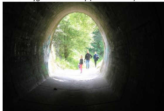
Fot. 22. Poterna pod drogą Władysławowo-Jastrzębia Góra (stanowisko 5)
