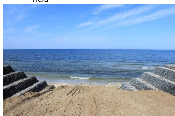
Fot. 121. Zdeprawione otwarcie widokowe przejścia na plażę przez wydmy między Jastrzębią Górą a Karwią
