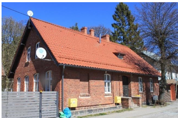
Fot. 11. Budynek mieszkalny z początku XX w. w Karwi
