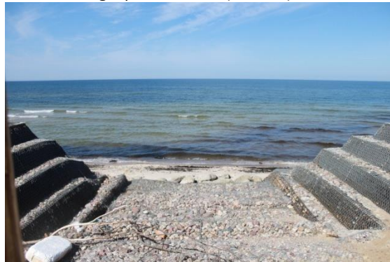
Fot. 51. Przejście między gabionami (fot. MP)
