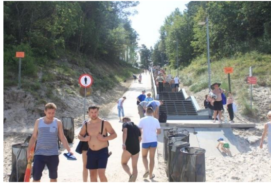
Fot. 55. Przejście po klifie schodami betonowymi (fot. MP)
