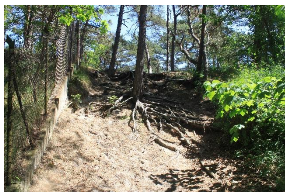
Fot. 86. Zniszczona powierzchnia terenu - przejście na plażę nr 59 w Juracie (fot. MP)
