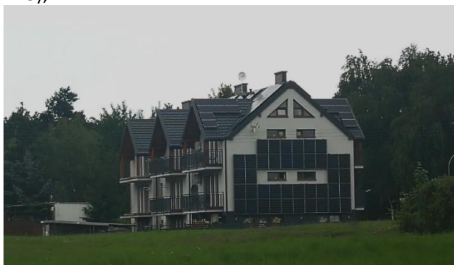
Fot. 115 Wykorzystanie odnawialnych źródeł energii negatywnie wpływających na krajobraz (przykład budynku w Kątach Rybackich) (fot. BJS 07.2020)
