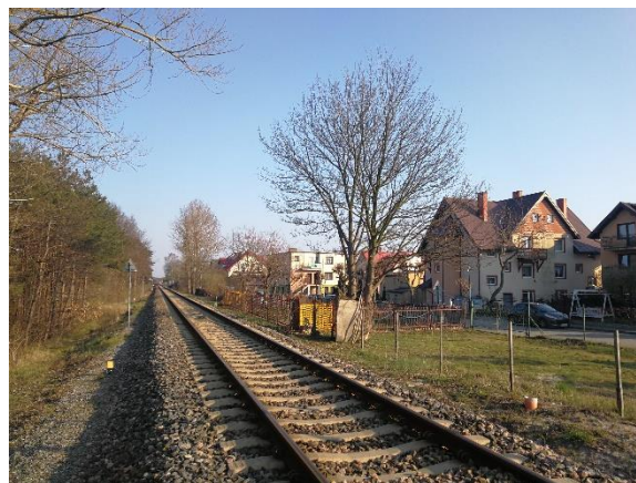
Fot. 82. Linia kolejowa w Chałupach (fot. BJS 04.2019)
