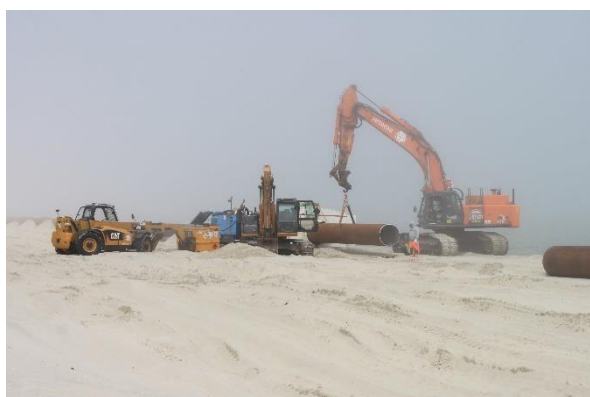
Fot. 91. Plac budowy rurociągu do transportu refułu na plaży koło Kuźnicy – czerwiec 2019 (fot. MP)
