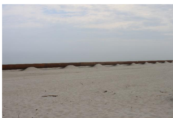
Fot. 92. Rurociąg do transportu refułu na plaży na wschód od Kuźnicy – czerwiec 2019 (fot. MP)
