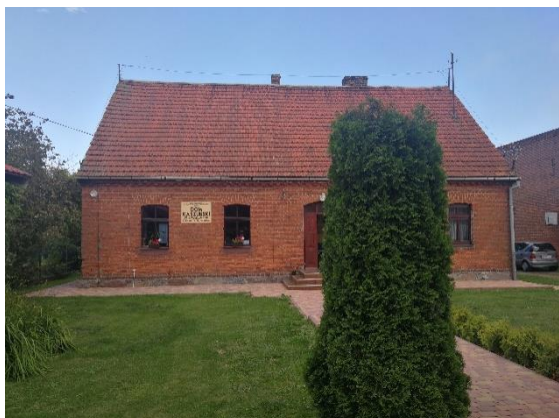
Fot. 67. Obiekt świetlicy w Swarzewie (fot. BJS 08.2019)
