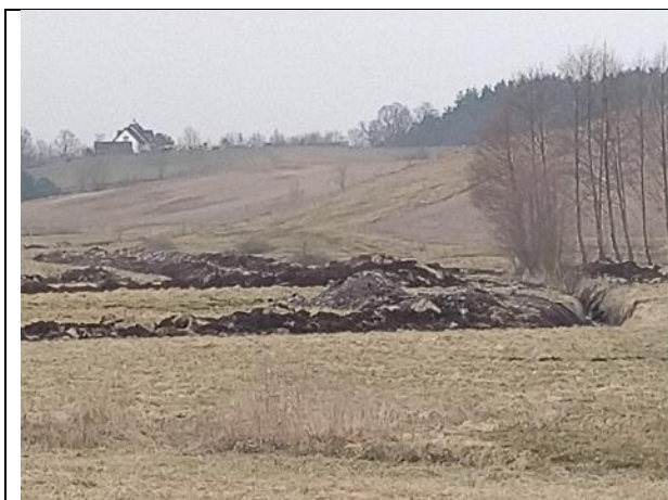
Ryc. 20 Przekopywanie rowów poniżej spągu gruntów organicznych, drenujące nie tylko same łąki ale obszary pól i lasów (zlewnia j. Cheb/Chebdy)
