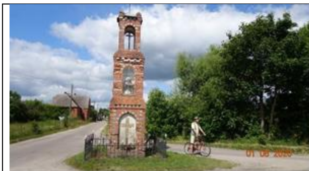
fot.63 Kliczkowy widok w kierunku drogi do Przytarni
