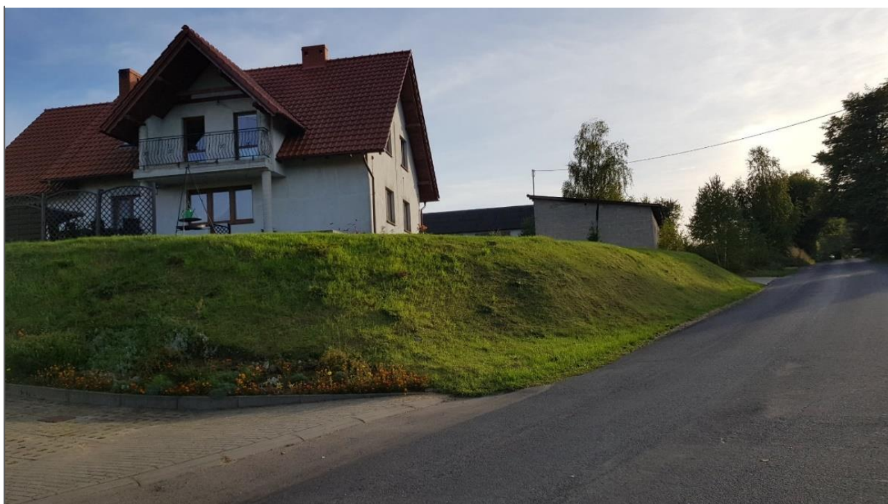
Fot. 7. Przykład niwelacji i terasowania terenu pod zabudowę we wsi Piechowice – zachodnia część WPK
