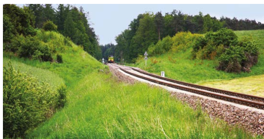
Nasyp i rozcięcie terenu na linii kolejowej koło Dziemian
